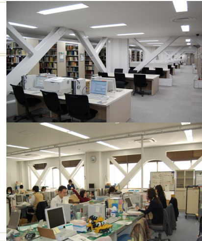
耐震補強の例 筑波大学中央図書館
