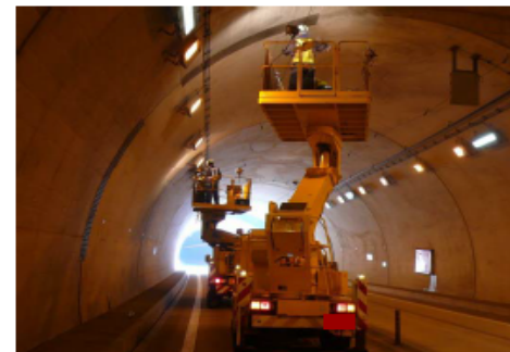
トンネル内 道路附属物点検
